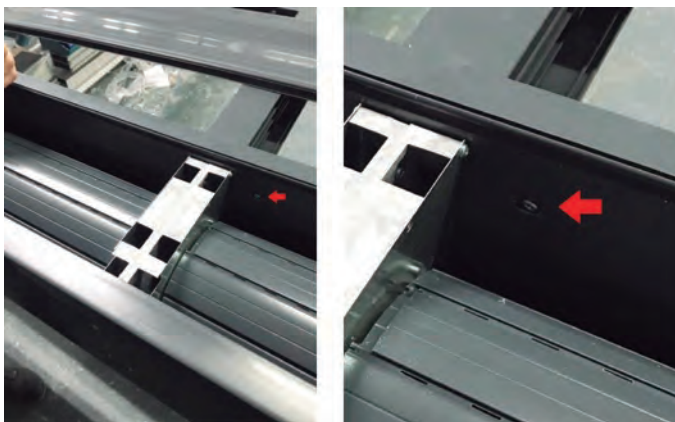
Figura 63. Detalle atornillado visto interiormente. Cuidado que la cabeza del tornillo no perfora el cajón.
