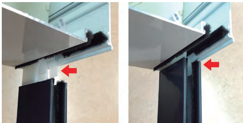
Figura 60. Unión ventana cajón
